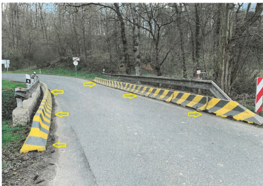
Obr. 1: Podél dodatečně instalovaných zábran jsou nečistoty, které udržují vlhkost. Trhliny ve vozovce jsou také zdrojem zatékání vody do konstrukce mostu.
