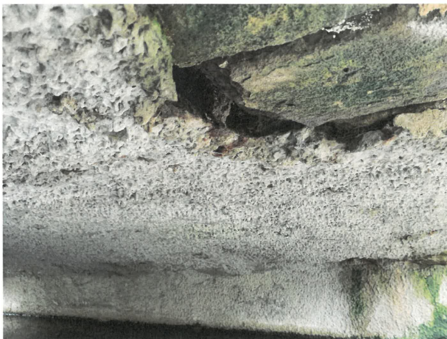
Obr. 10: Detail odtržené části torkretu na spodním líci klenby. Mezi torkretem a kamenným zdivem je patrná dutina. U paty klenby jsou jedna vodorovná a dvě svislé trhliny s vytékající vodou z konstrukce mostu.
