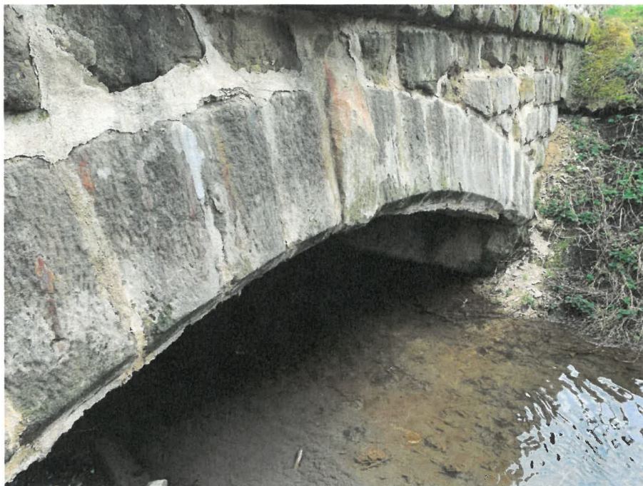
Obr. 6: Održená spárovací malta od zdících prvků na levé straně mostu. Přes tato místa dochází k vytékání vody z konstrukce mostu.
