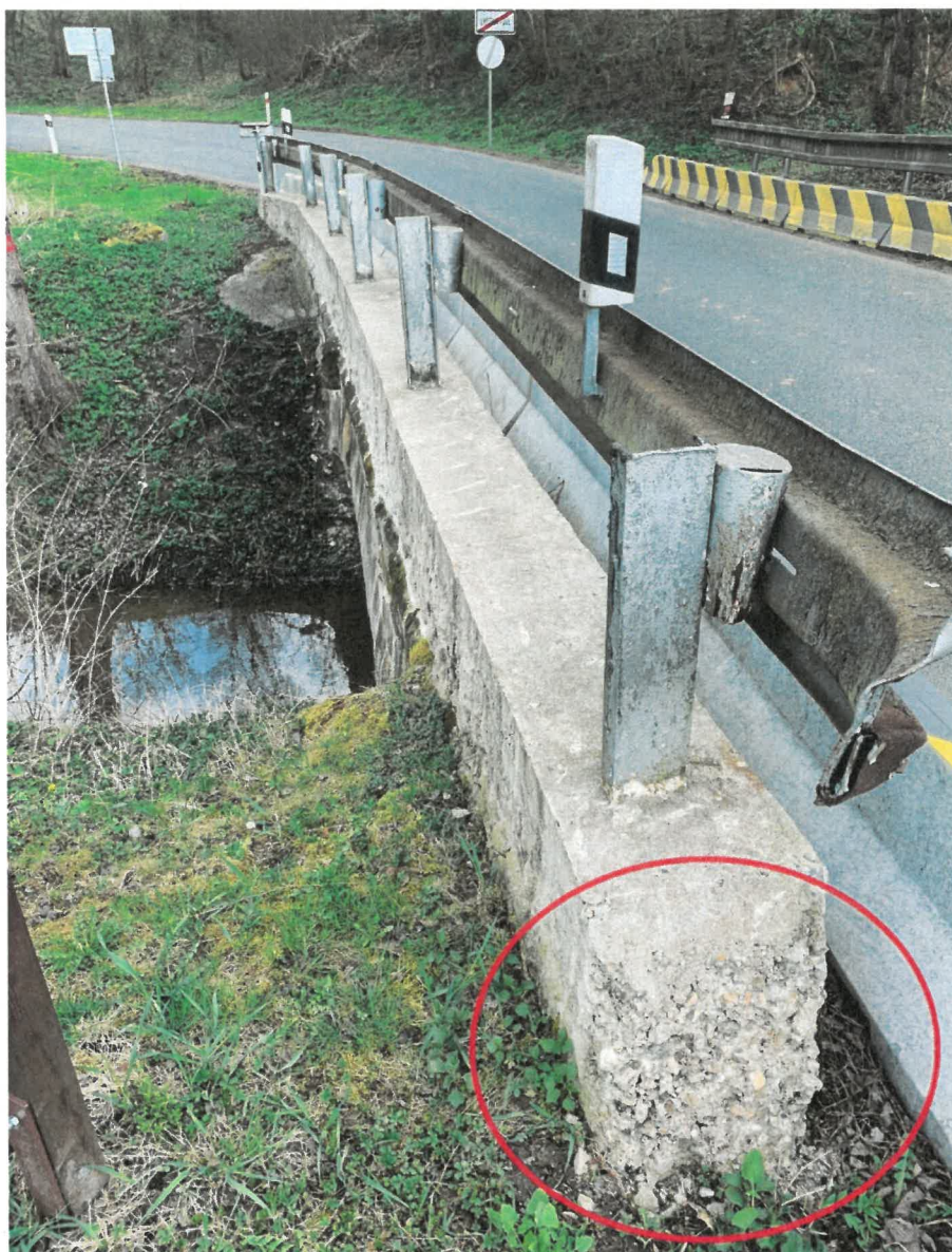
Obr. 2: Mrazem rozpadlá struktura betonové parapetní zídky. Poškozené svodidlo od nárazu vozidla.
