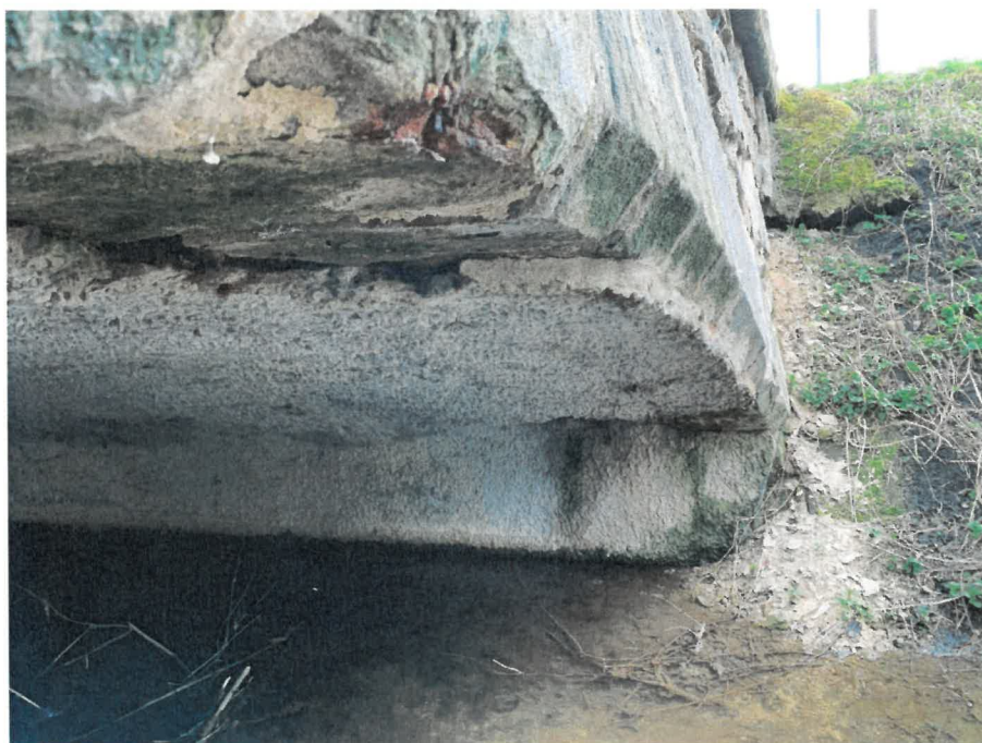
Obr. 9: Održžená část torkretu na spodním líci klenby. Mezi torkretem a kamenným zdivem je patrná dutina. U paty klenby je jedna vodorovná a dvě svislé trhliny s vytékající vodou z konstrukce mostu.
