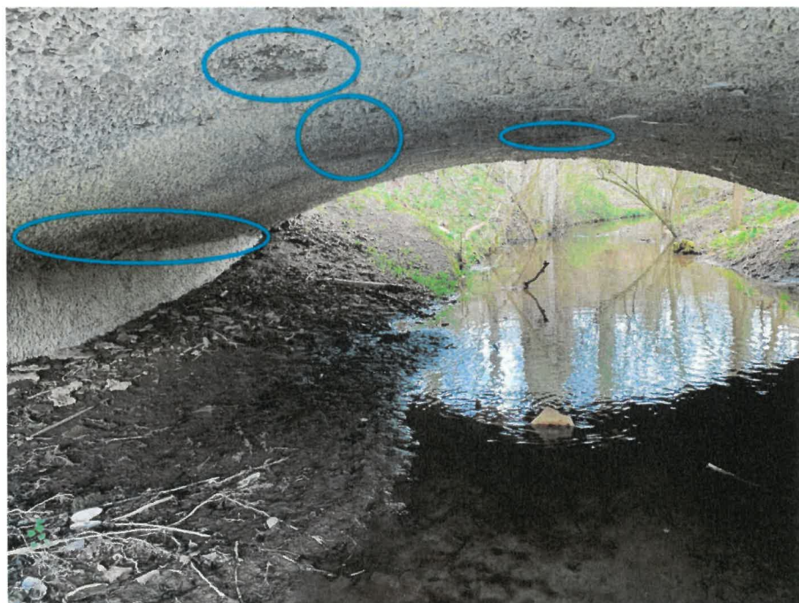
Obr. 15: Spodní klenby kamenného mostu. Na obrázku jsou vyznačena místa průsaků vody z klenby přes vrstvu torkretu.
