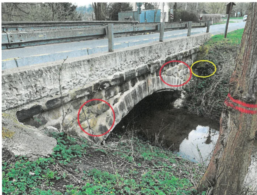
Obr. 4: Porušené dodatečně opravované spárování nadezdívky na levé straně mostu (označeno červeně). Usmyknutý břeh potoka (označeno žlutě).
