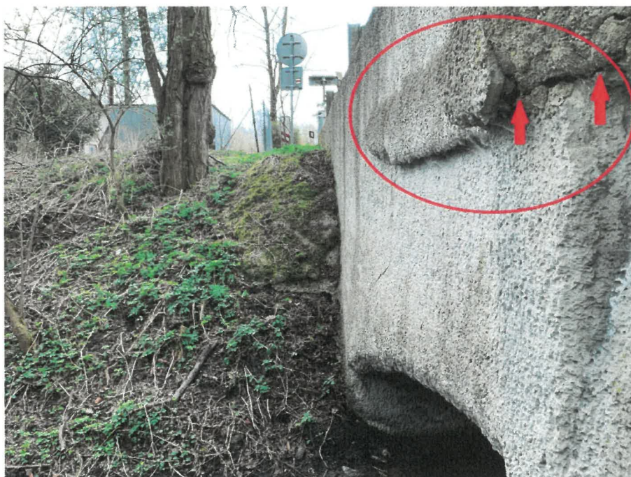
Obr. 14: Detail trhliny v torkretu pod částí původní předsazené kamenné římsy a vrcholovým klenákem (označeno červeně). Pod touto oblastí je svislá trhlina s vytékající vodou z konstrukce kamenného zdiva.
