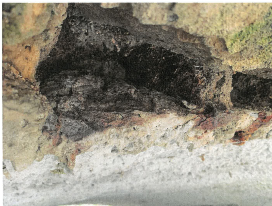
Obr. 11: Detail odtržené části torkretu na spodním líci klenby, resp. rozrušené zdící malty kamenného zdiva.
