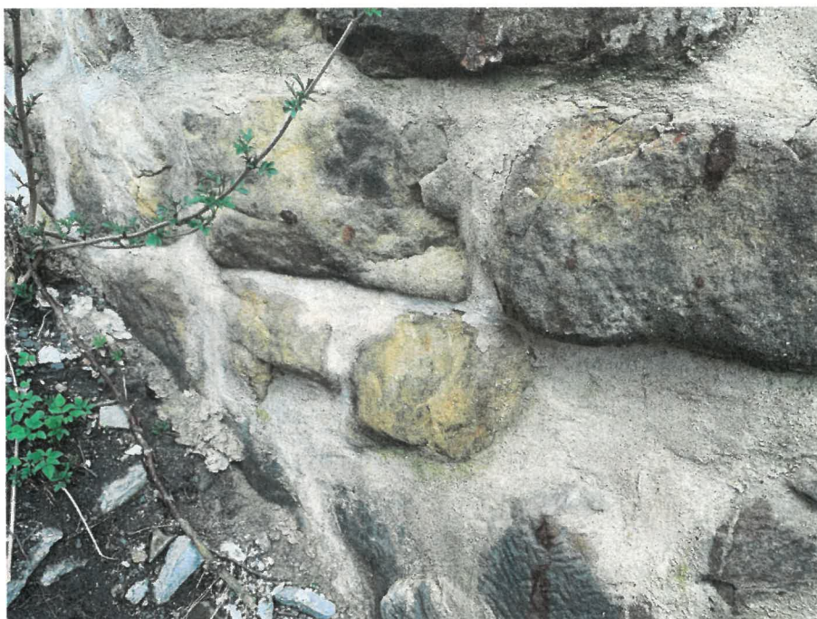
Obr. 8: Trhliny v opravné spárovací maltě kamenného zdiva nadezdívky na levé straně mostu.
