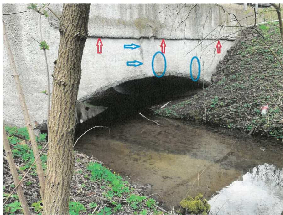
Obr. 13: Trhlina v torkretu pod částí původní předsazené kamenné římsy a vrcholovým klenákem (označeno červeně). Na obrázku jsou vyznačeny vlhké oblasti nebo trhliny s vytékající vodou z kamenného zdiva (označeno modře).
