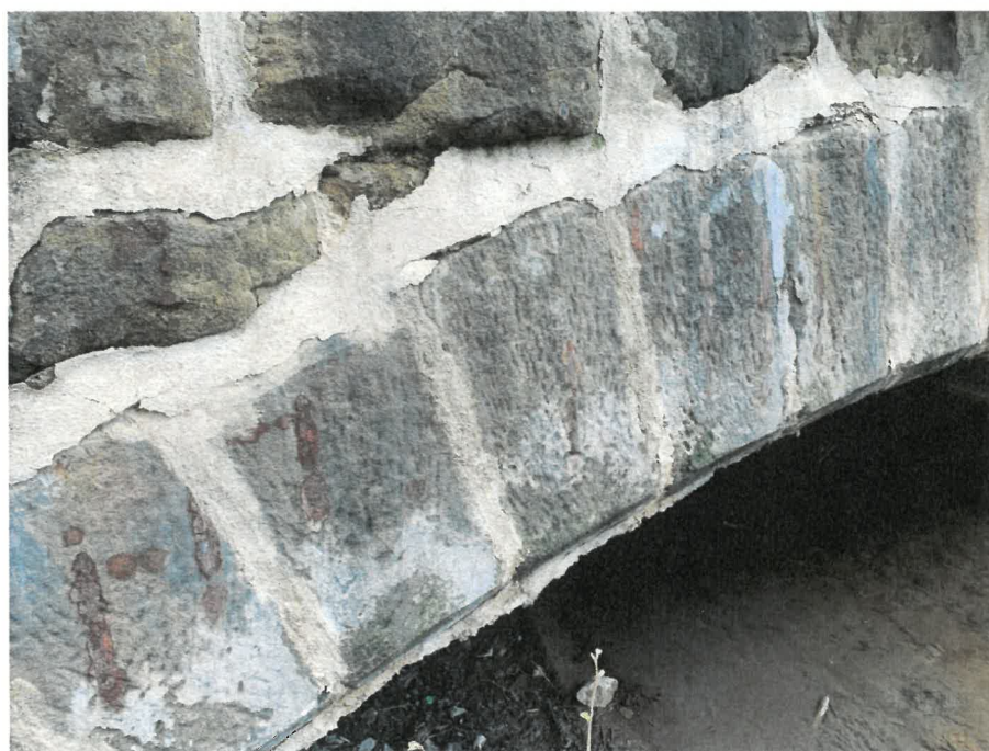
Obr. 7: Održená spárovací malta od zdících prvků na levé straně mostu. Přes tato místa dochází k vytékání vody z konstrukce mostu.
