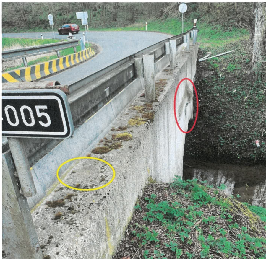
Obr. 12: Pravá strana mostu je uzavřena vrstvou torkretu. Na parapetní zídce jsou nerovnosti, ve kterých se zadržuje voda (označeno žlutě). Torkret byl nanesen na část původní předsazené kamenné římsy a vrcholový klenák (označeno červeně). Pod touto oblastí je trhlina s vytékající vodou a vápennými výluhy.
