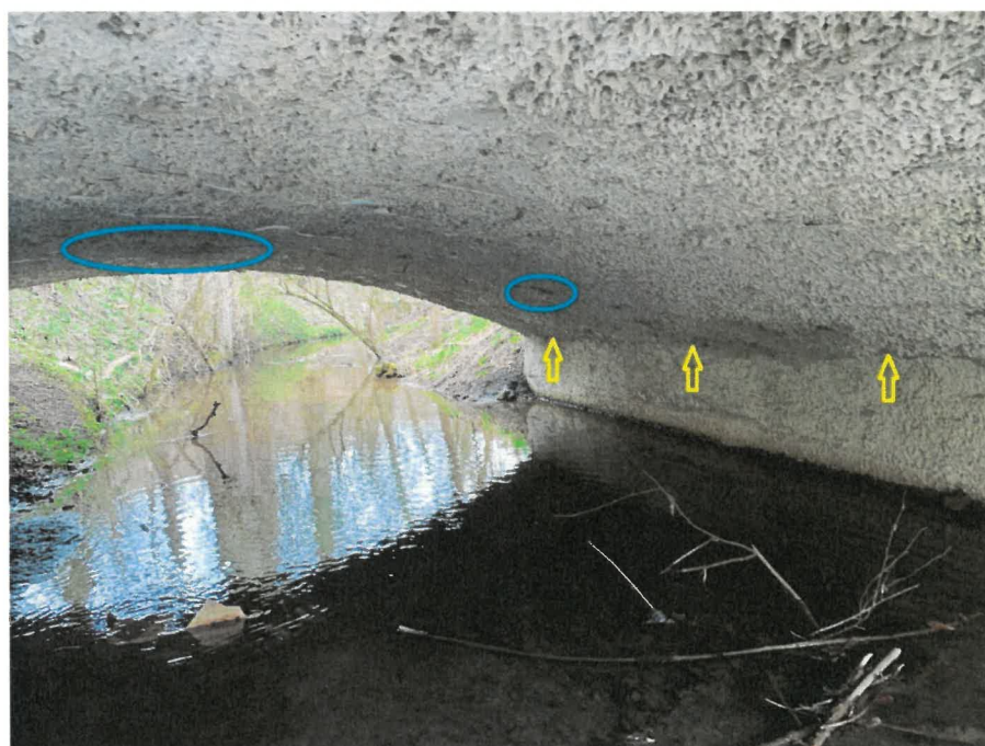
Obr. 17: Spodní klenby kamenného mostu. Na obrázku jsou vyznačena místa průsaků vody z konstrukce klenby přes vrstvu torkretu (označeno modře). V torkretu byla u paty klenby zjištěna vodorovná trhлина (označeno žlutě).
