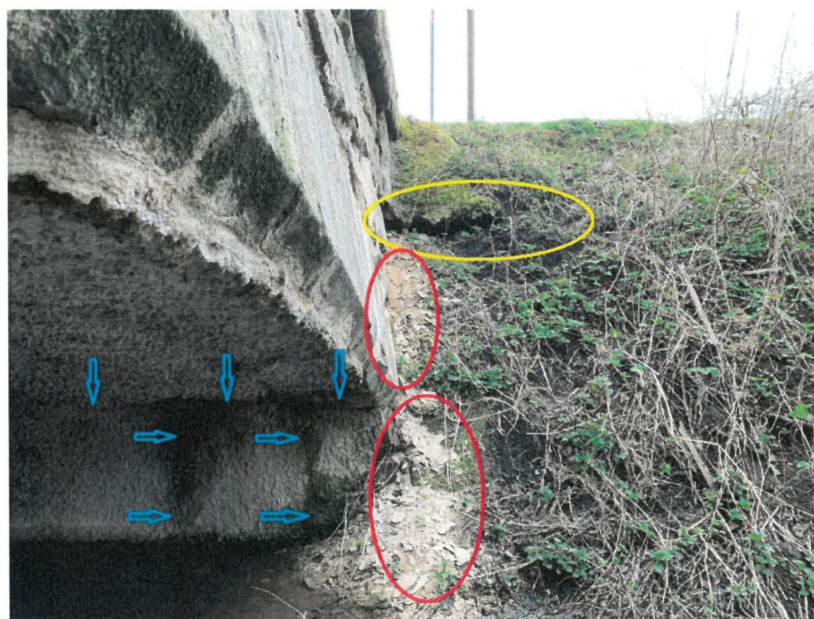
Obr. 5: Odpadnuté části degradované spárovací malty a torkretu na levé straně mostu (označeno červeně). Detail usmyknutého břehu potoka (označeno žlutě). U paty klenby jsou jedna vodorovná a dvě svislé trhliny s vytékající vodou z konstrukce mostu (označeno modře). Povrch torkretu je v tomto místě zcela odtržený od podkladu.
