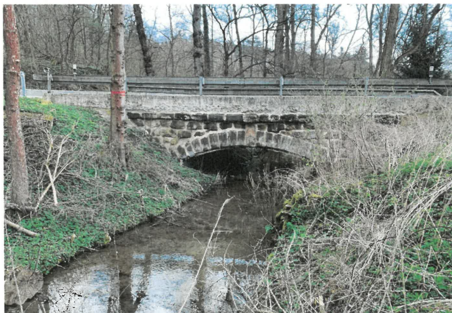
Obr. 3: Pohled na levou stranu mostu, kde došlo k plošnému odpadnutí torkretu.
